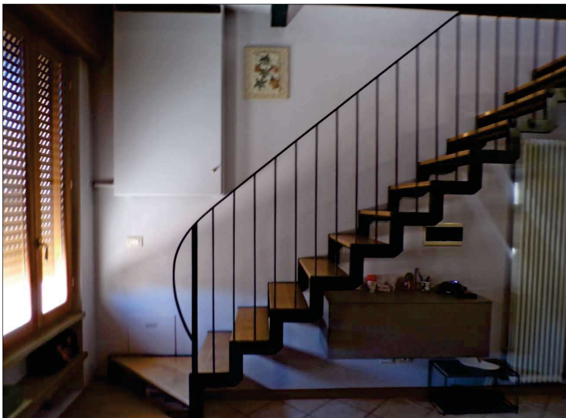
FOTO N. 4: Particolare scala di collegamento fra P3 e P4
