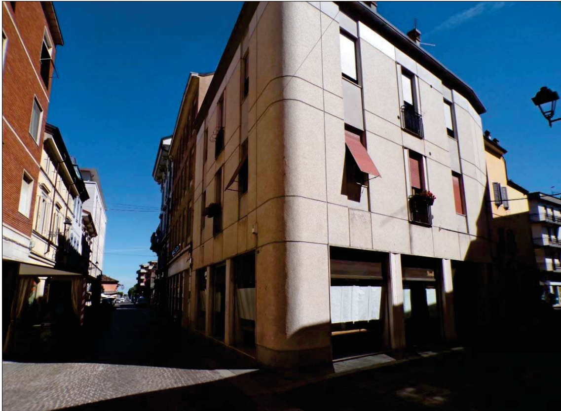
FOTO N. 1: Prospetto fabbricato su C.so Garibaldi
