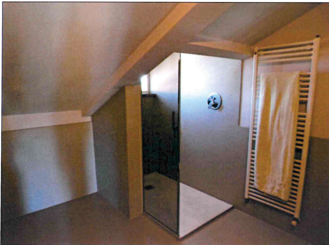
FOTO N. 8: Particolare servizio igienico P4
